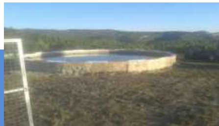
Mantenimiento de depósitos de la red contra incendios forestales
