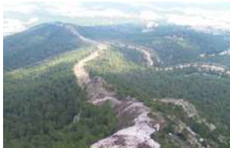
Ejecución de las obras del IV mantenimiento del proyecto piloto de selvicultura preventiva en el Valle de Ayora (Valencia)
