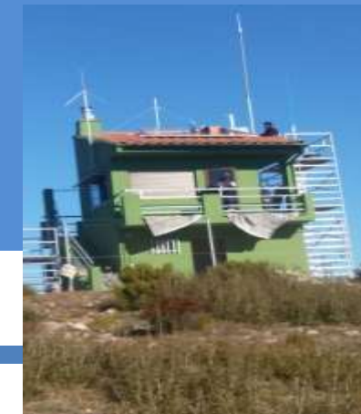
Mantenimiento de Observatorios Forestales para Prevención de Incendios
