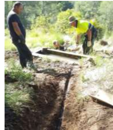
Mantenimiento de Infraestructuras de Prevención de Incendios Forestales en la Demarcación de Valencia Sur
