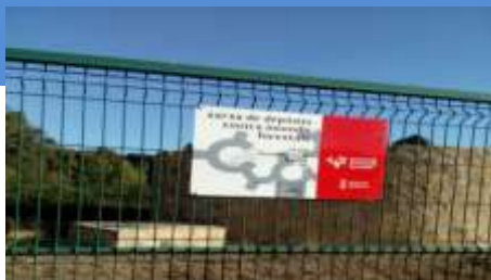
Reparación vallado y señalización en Infraestructuras de Prevención de Incendios forestales
