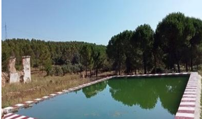
Mantenimiento y reparación de depósitos de agua contra incendios forestales
